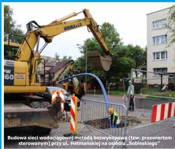
Budowa sieci wodociągowej metodą bezwykopową (tzw. przewiertem sterowanym) przy ul. Hetmańskiej na osiedlu „Sobieskiego”
