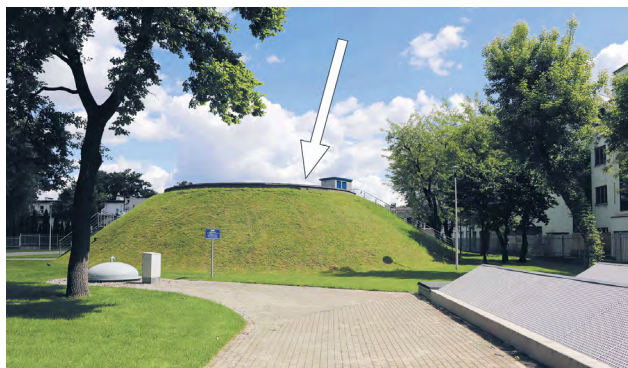
Zbiorniki wody czystej na SUW „Jagiellońska”
