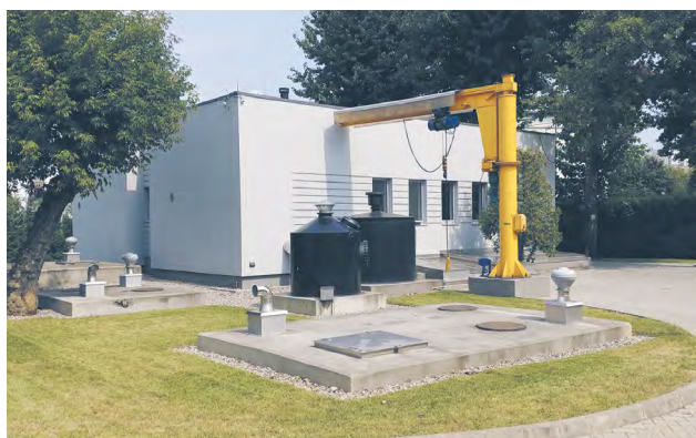
Przepompownia Ścieków „Centralna”
