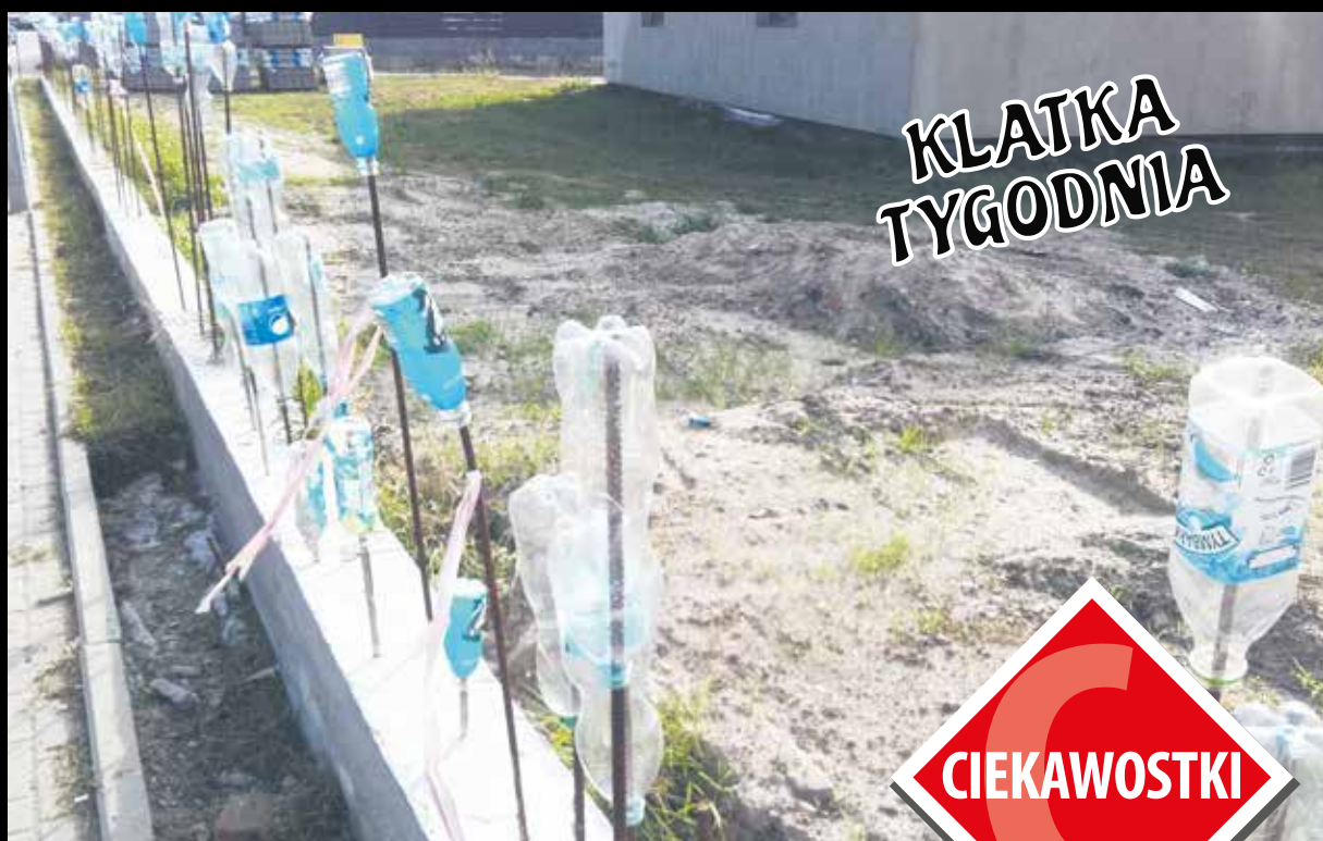
Na tej budowie w kwestii bezpieczeństwa nie nabijają w butelkę! fot. red.
